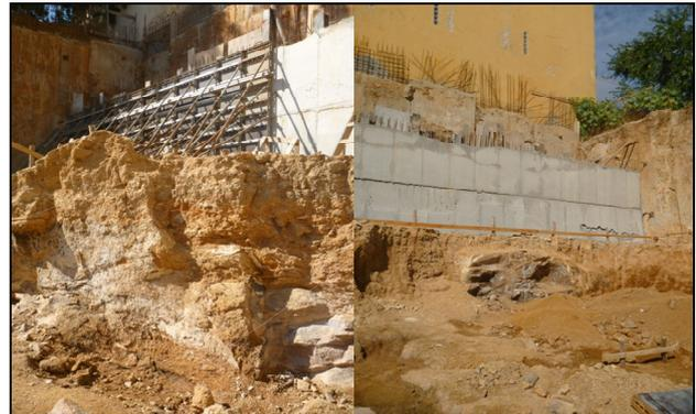
Figura 12: concretagem das contenções em módulos horizontais e verticais (setor B)
