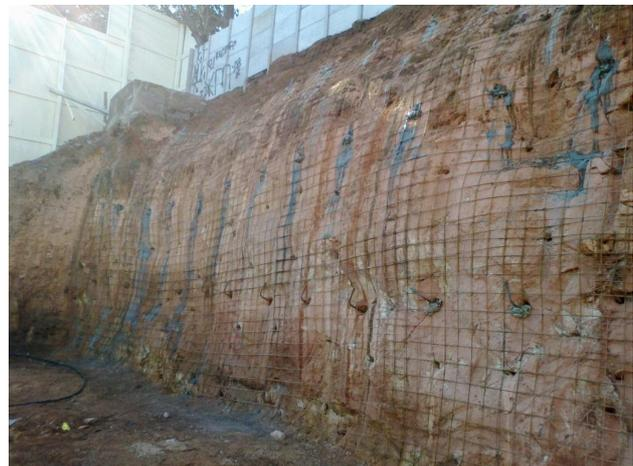
Figura 29: talude antes da execução do paramento
