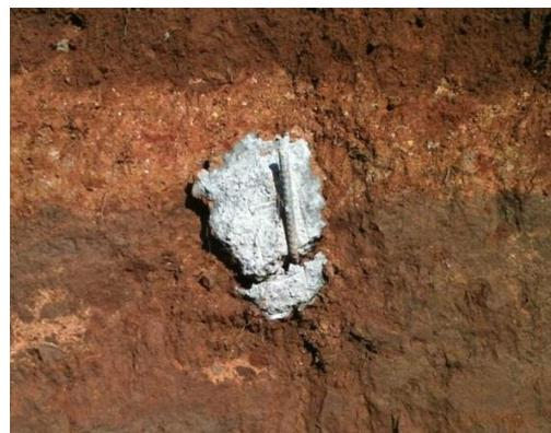
Figura 34: grampo que se desprendeu do paramento
