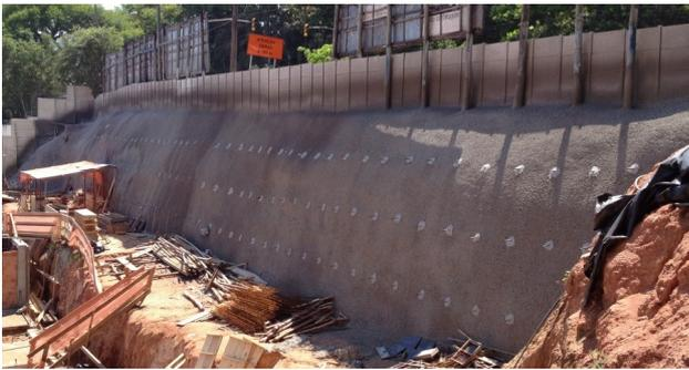
Figura 30: talude após a execução do paramento de concreto projetado
