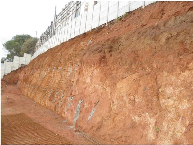
Figura 21: talude onde foi empregada a técnica do solo grampeado
