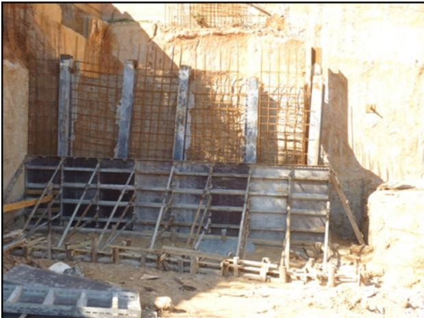
Figura 10: execução da contenção no setor A
