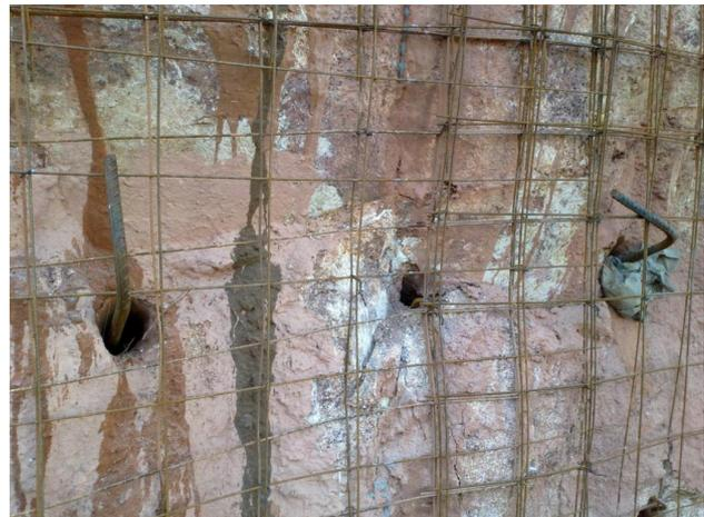
Figura 24: grampos e tela metálica do paramento
