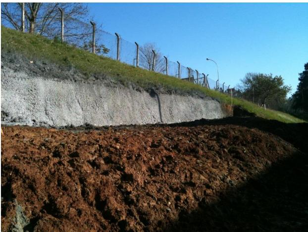
Figura 31: solo grampeado no trecho do talude onde ocorreu a ruptura
